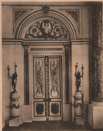
BOCZNE DRZWI SALI KOLUMNOWEJ
