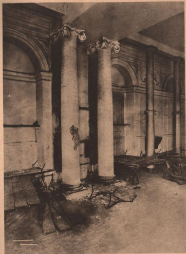
RUINY BIBLIOTEKI PRZED JEJ RESTAURACJĄ
