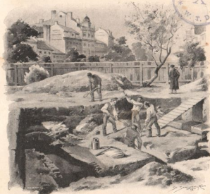
Kopanie dołu pod fundamenty
